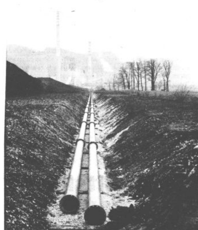
Trasa povratnega cevovoda je že utrjena, namestiti je treba le še nekaj cevi
