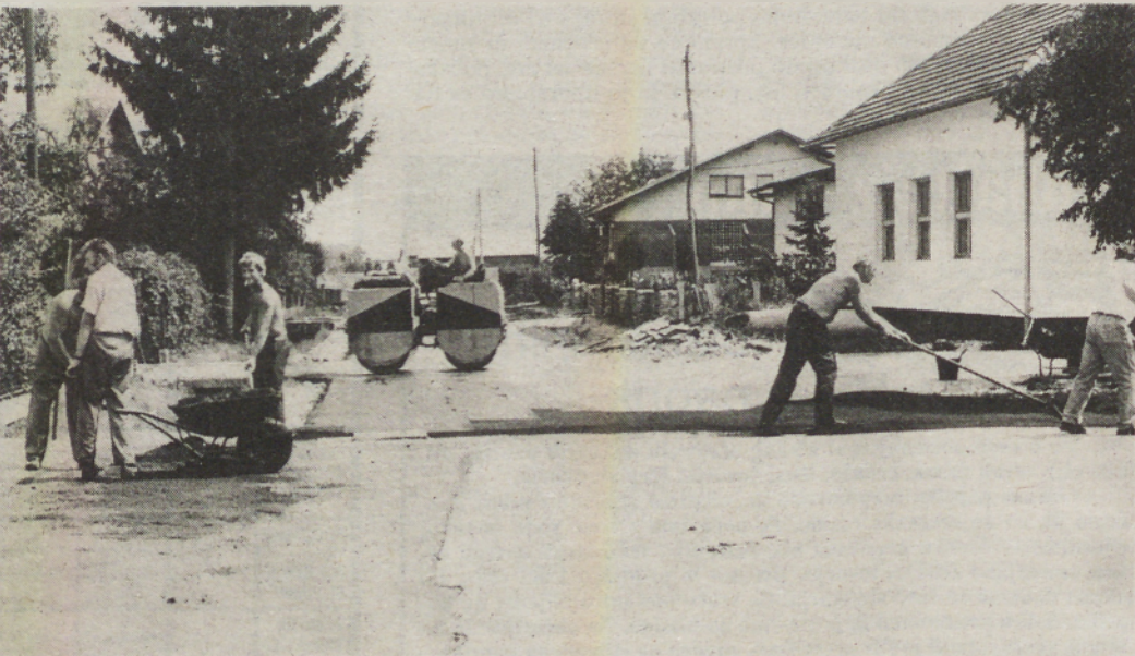
ZAKRPALI CESTE — Delavci SGP Pom-grada so imeli te dni kar precej dela v Veščici, kjer je bilo treba ponovno asfaltirati (zakrpati) vaške ceste. Le-te so prekopali delavci Vodnogospodarskega podjetja Mura, ki so napeljali kanalizacijo.
