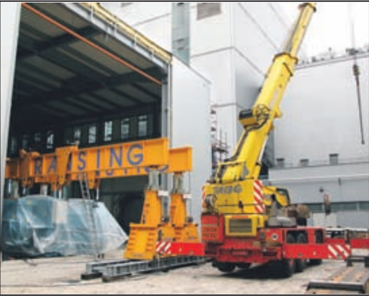
Vzporedno s sinhronizacijo prve plinske turbine je potekala tudi montaža druge. Ko bo vsa oprema na svojem mestu, bodo prostor povsem zaprli.
