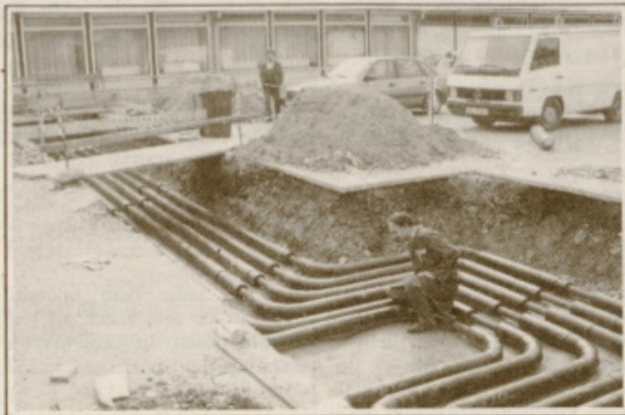
Delavci so vse delo opravili v popoldanskem času, tako da niso motili pouka.
