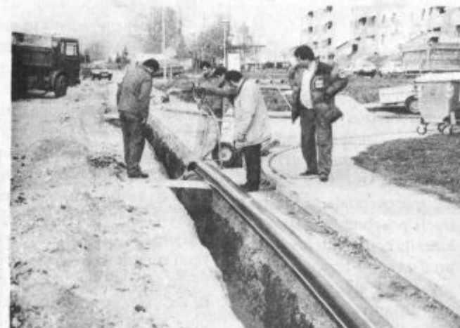
Delavci Mestnega plinovoda Koper v teh dneh pri gradnji sekundarnega voda.
