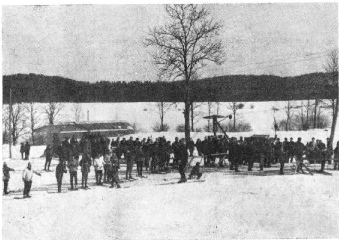
Smučarska vlečnica v Črnem vrhu, ki je začela obratovati 30. januarja 1966
