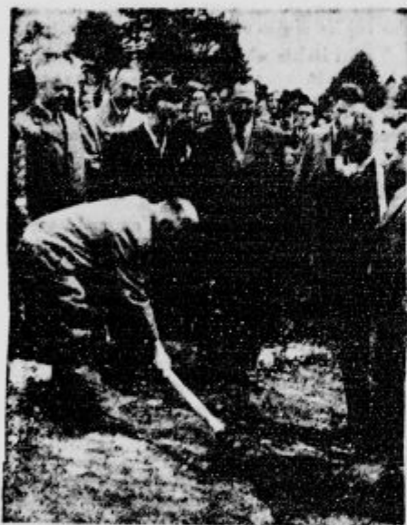
Minister dr. Spaho je zasadil prvi kramp in s tem dal znamenje, da so se dela za progo Črnomelj-Vrbovsko začela
