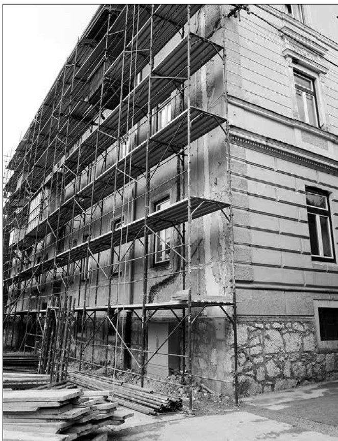
Izvajalec obnove gornjegrajske »posojilnice« bo najprej odstranil poškodovane zidane in ometane površine. (Foto: Štefka Sem)
