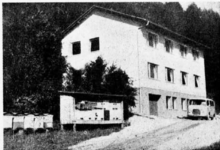
Nova čebelarška šola tik pred dograditvijo. Poslopje je sredi lepega ograjenega vrta. Vsa lega je odprta proti jugovzhodu, s severa pa jo varuje z gozdom porasel hrib.
