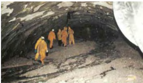
Slika 2: Kalota na stacionaži TM3020 m po vdoru vode in razbrebenilna vrtina za zmanjšanje vodnega pritiska (Mikoš in sod., 1991).
