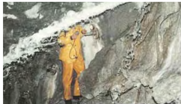
Slika 2: Kalota na stacionaži TM3020 m po vdoru vode in razbrebenilna vrtina za zmanjšanje vodnega pritiska (Mikoš in sod., 1991).
