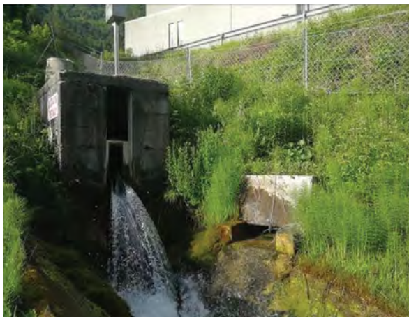
Slika 7: Iztok iz zahodne cevi (levo) in vzhodne cevi (desno) med gradnjo vzhodne cevi predora.
