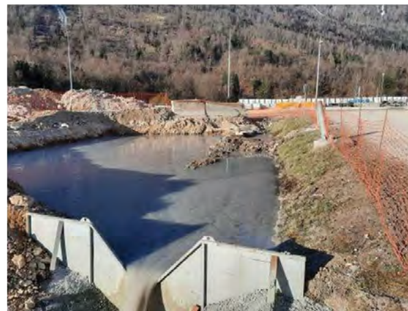
Slika 7: Iztok iz zahodne cevi (levo) in vzhodne cevi (desno) med gradnjo vzhodne cevi predora.
