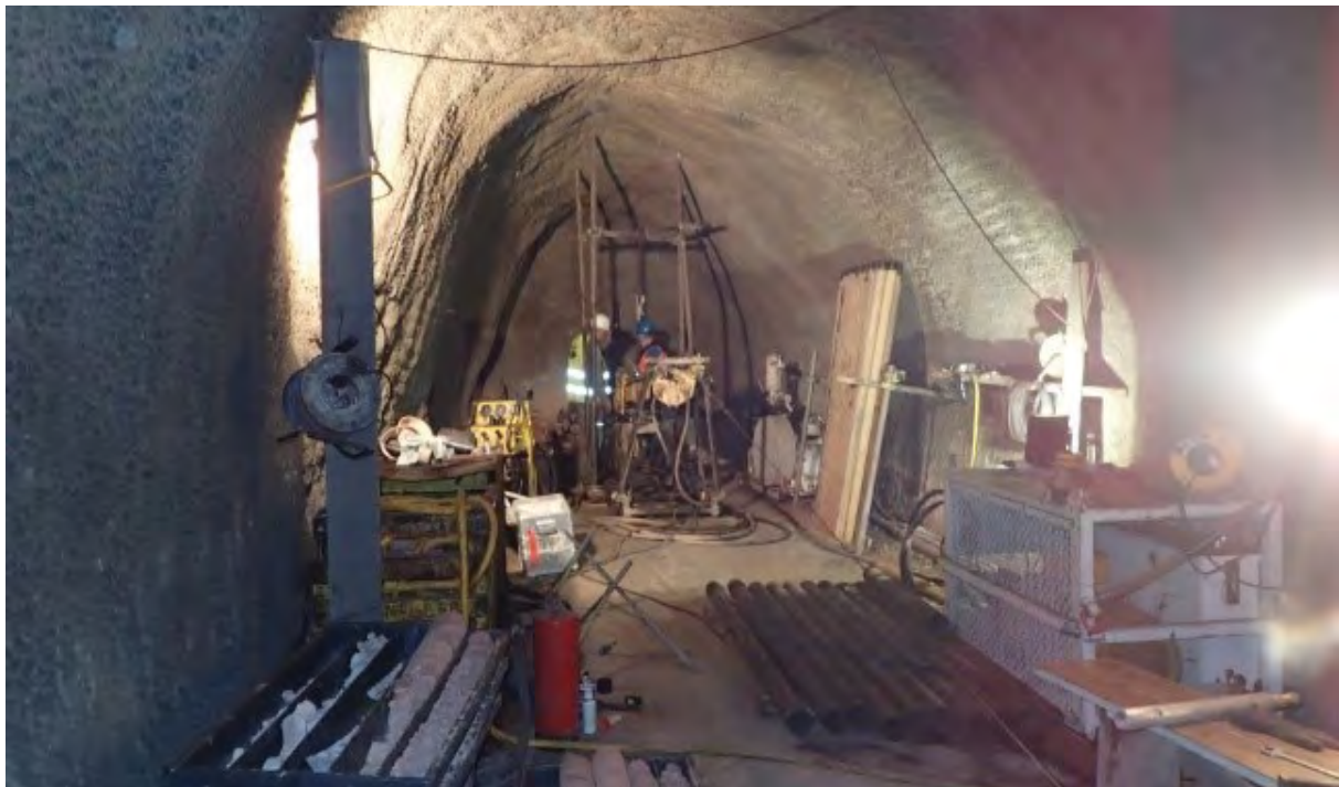
Slika 3: Izvedba vrtanja v prečnikih prve cevi.
