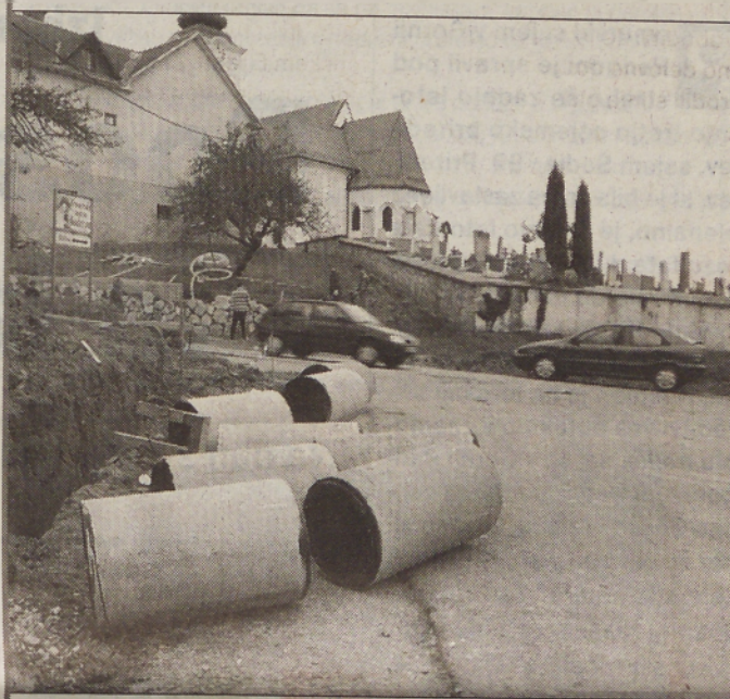
Zidava podpornega zidu, položitev kanalizacije in ureditev pločnika v središču Jurovskega Dola.
