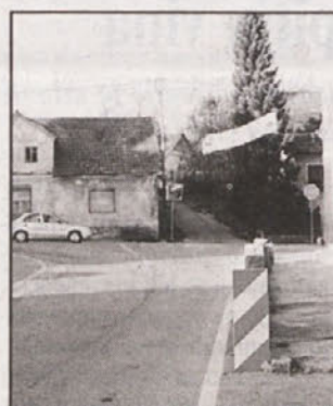
OPOZORILO ZALEGLO - Pred dobrim mesecem dni smo na teh straneh opozorili na nevarnost v Smrečnikovi ulici v Smihelu. Gre za betonski zid ob cesti zraven žu-pnišča, ki ga voznik celo podnevi težko opazi. Marsikdo se mu je še zadnji trenutek izognil ali pa mu to ni uspelo in je vanj trčil. Zdaj ni več tako, saj so zidek opremili z ustreznim odsevnikom, da je viden tudi ponoči. Kdorkoli je že zaslu-žen za to, temu gre vsa pohvala. Očitno je včasih potrebna samo be-seda, pa se vse uredi. (Foto: L. M.)
