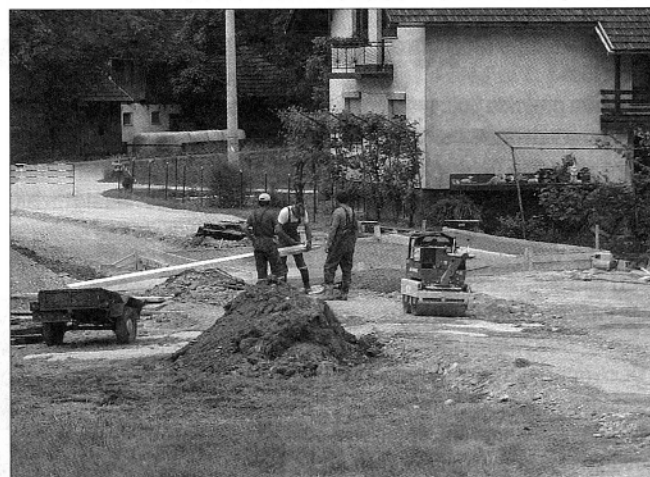
Preko Grušoveljske struge bo vodil nov most (foto: Marija Lebar)
