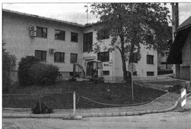
Po dokončanju zunanjih del bosta na obnovo čakali še notranjost zdravstvenega doma in fasada (foto: Benjamin Kanjir)
