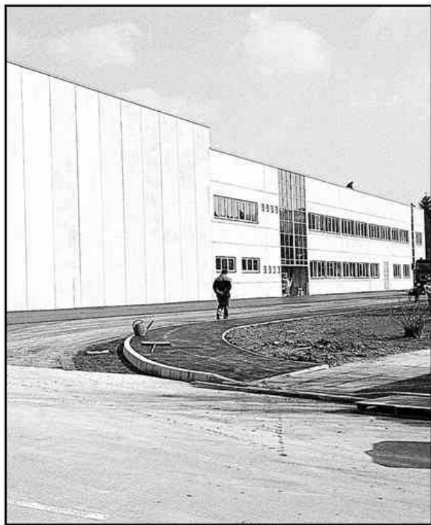
Gradbena dela so zaključena, zdaj urejajo okolico
