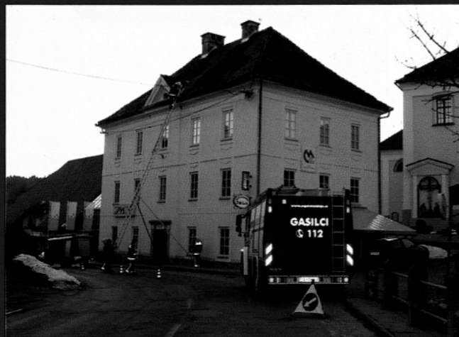
Gasilci so po dolgi lestvi splezali na streho in premaknjeni strešnike vrnili na njihovo mesto (foto: Benjamin Kanjir)
