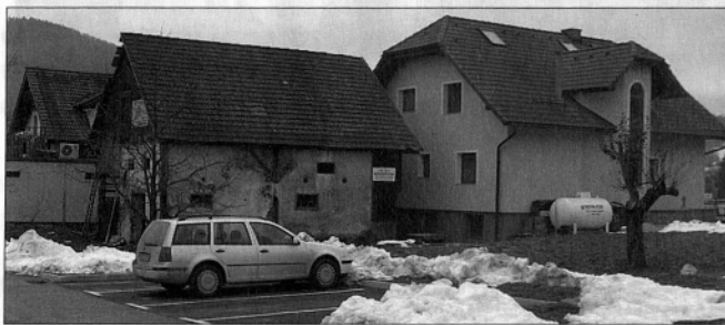
Dotrjani objekt bo naslednje leto zamenjala kotlovnica na biomaso (foto: Benjamin Kanjir)
