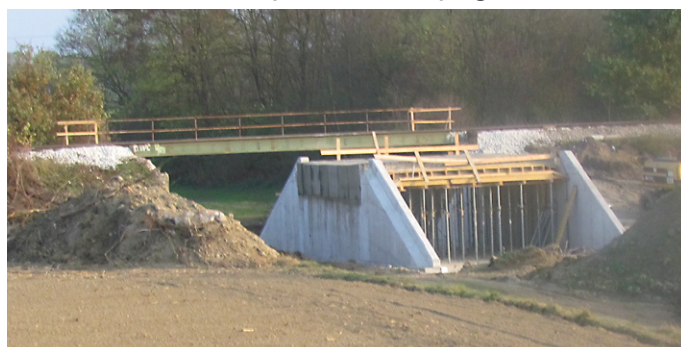
Novi most pripravljen za namestitev pod železniško progo (na progi so vidni začasni nosilci).
