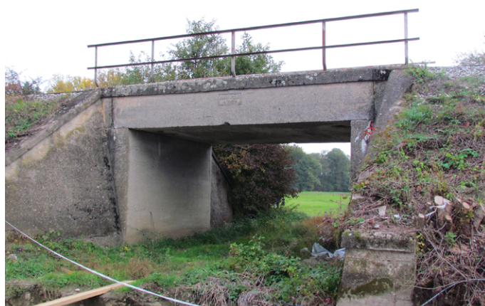
Armiranobetonski most pod železniško progo iz leta 1935.
