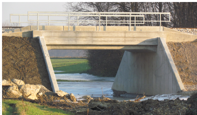
Novi most nameščen pod železniško progo.
