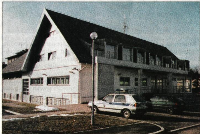
Stavba škofjeloške policije je najmlajša na Gorenjskem.
