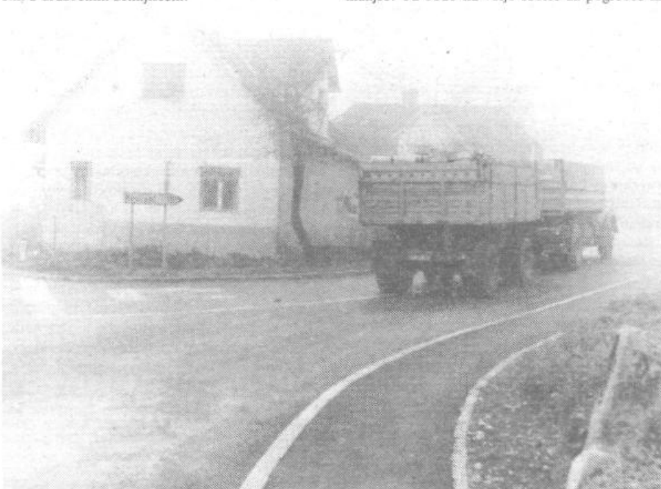
Prvi kilometri asfalta proti Mali Slevici
