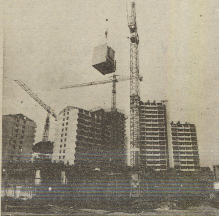
Montaža kopalnice VARIS v objekt.
