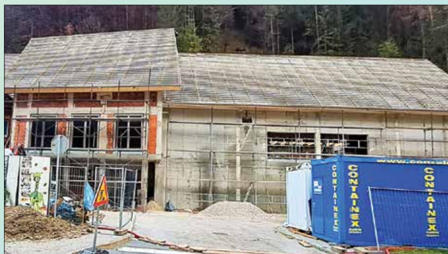
Telovadnica pri osnovni šoli v Solčavi bo še pred snegom pod streho.
