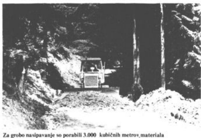
Za grobo nasipavanje so porabili 3.000 kubičnih metrov materiala
