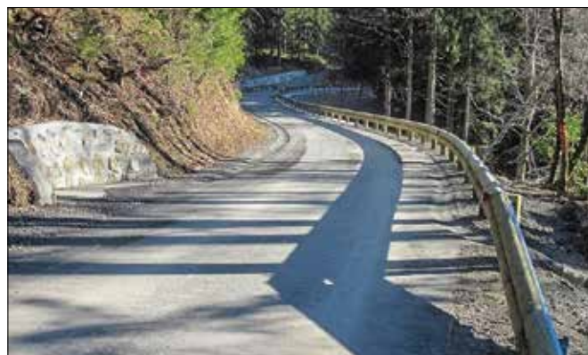
Na odseku Žibovt-Sveti Duh-Podolševa so potekala dela na sanaciji dveh plazov. (Fotodokumentacija DRSI)
