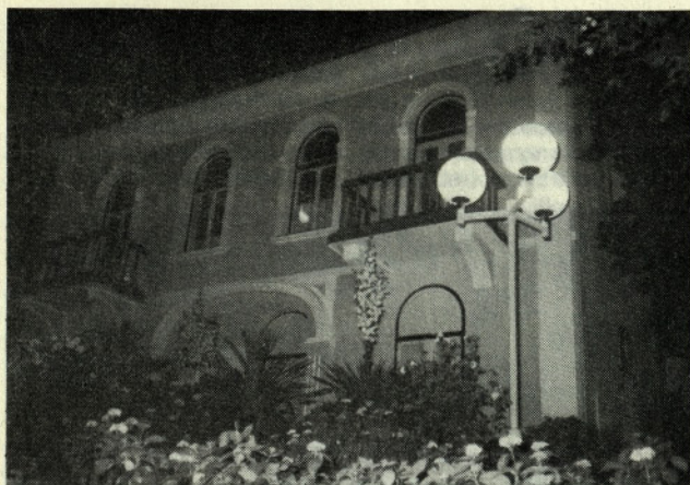
Čeprav je bila stavba zgrajena okoli leta 1925 je bilo mnogo takšnih, ki so komaj čakali, da jo prodamo. Verjetno smo si danes vsi enotni, da smo storili edino prav, ko smo se odločili za obnovo.
