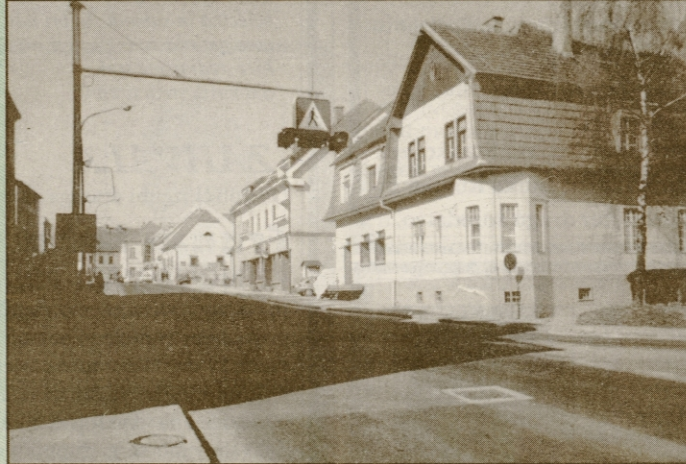
Cesto skozi Lenart bodo obnovili do križišča za Cmurek pri lekarni.
