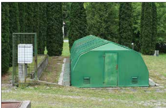
Obstoječo čistilno napravo, ki ni več funkcionalna, bo nadomestila nova s sodobno tehnologijo.
