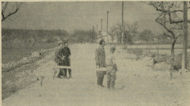
Naporna so dela na cesti Braslovče—Žovnek zaradi mehkih in mokrih ilovnatih tal. Cesta bo mnogo cenejša od predračunske vsote, ker opravlja delovna enota vsa pripravljala dela za asfaltiranje sama.
