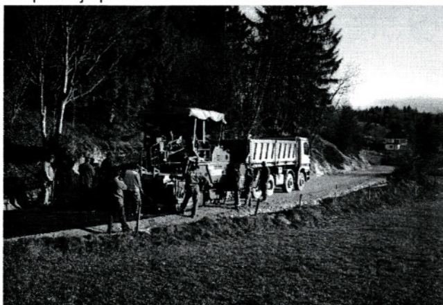
Med polaganjem asfaltna prevleke (Foto R.B.)
