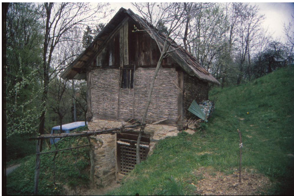
Fotografija 16: Klečaja (vinska klet) s kamnito in delno vkopano kletjo ter iz z vej pletenim pritličjem. Vito Hazler, Sovjak, 1992.
