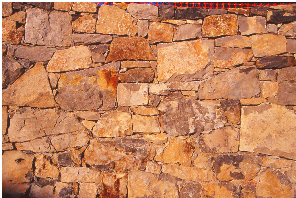
Fotografija 6: Na suho grajeni kamnit zid brez veziv, le s tesno prilegajočimi se kamni. Vito Hazler, Škocjan, 2002.
