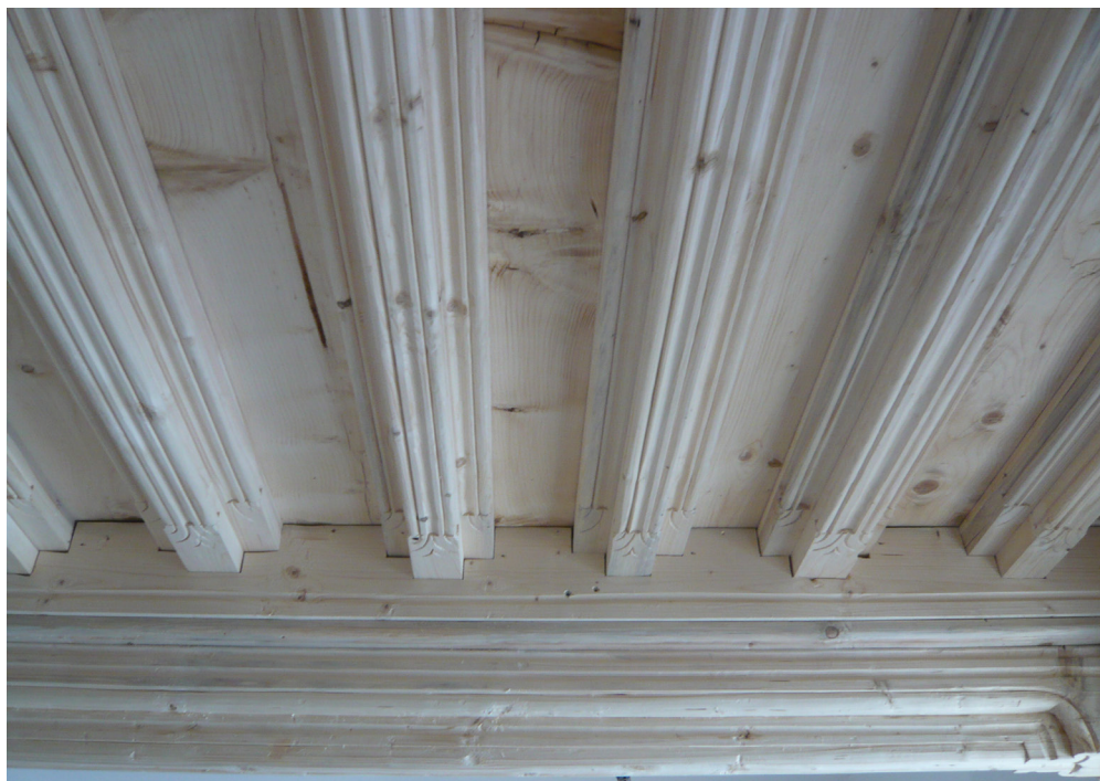
Fotografija 42: Po obnovi številnih lesenih stropov si je vrhunski mizar in restavrator Andrej Grom izdelal lesen strop še za svoj dom. Replika poznorenesančnega stropa v novi stanovanjski hiši je dokaz mizarjevega poznavanja gradiv, tehnologij, slogovnih prvin in estetike. Vito Hazler, Logatec, 2010.
