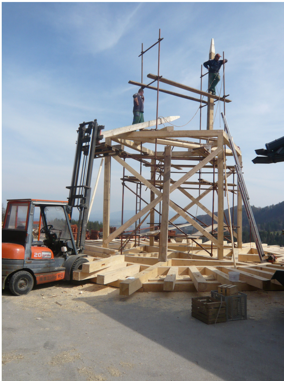
Fotografija 5: Tesarstvo in krovstvo Podgrajšek Ivan. Izdelava in montaža ostrešja za cerkveni stolp na domačem dvorišču, nato so ostrešje razstavili, naložili na kamion in v kratkem času ponovno sestavili na cerkvenem zvoniku. Vito Hazler, Zlakova nad Zrečami, 2013.
