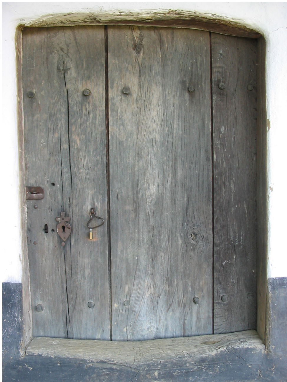
Fotografiji 32 in 33: Filovski Breg, Filovski Vrež , vinska klet, lastnik Jožef Török. V osrednji vhodni prostor vodijo enokrilna vrata z z lesenimi klini pritrjenimi deskami. Levo so stanovanjski prostori, desno deloma vkopana lesena in z ilovico ometana klet, kjer je poleti, ko zunanje temperature krepeko presegajo 30 °C, tudi za 10 °C hladneje. Vito Hazler, Filovci, 2006.
