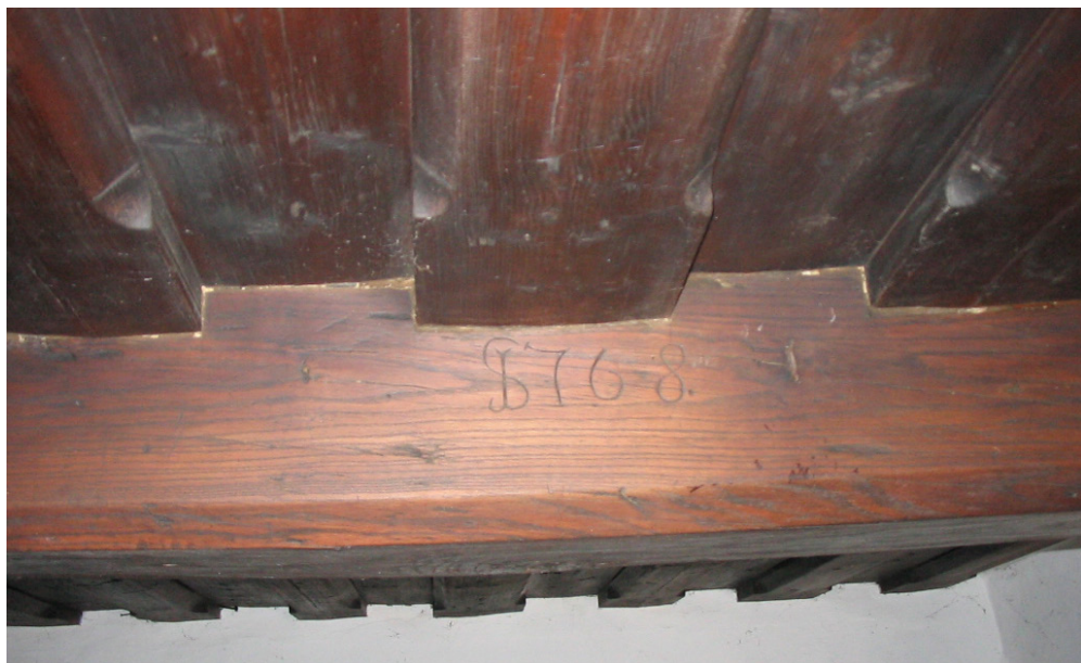
Fotografija 39: Lesen strop s prečnim tramom in nanj vrezano letnico 1768, spodnje plasti desk so nekaj centimetrov pred stikom s tramom okrašene z rahlo ukrivljenimi ajdovimi zni. Vito Hazler, Zgornji Brnik, 1998.
