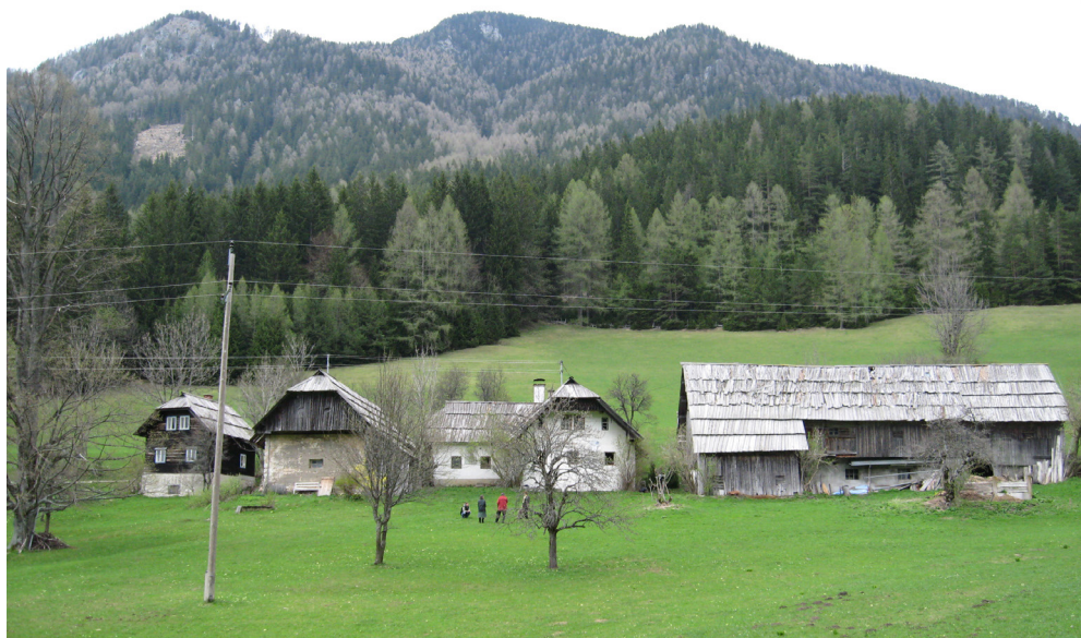
Fotografija 3: Pogled z juga na domačijske stavbe, ki so v celoti prekrite z žaganimi deskami. Na južni strani s posnetka se deske pogosteje in hitreje ukrivijo ter posledično hitreje propadejo kot na prisojni severni strani, kjer jih prerašča mah in so vlažne večji del leta.
