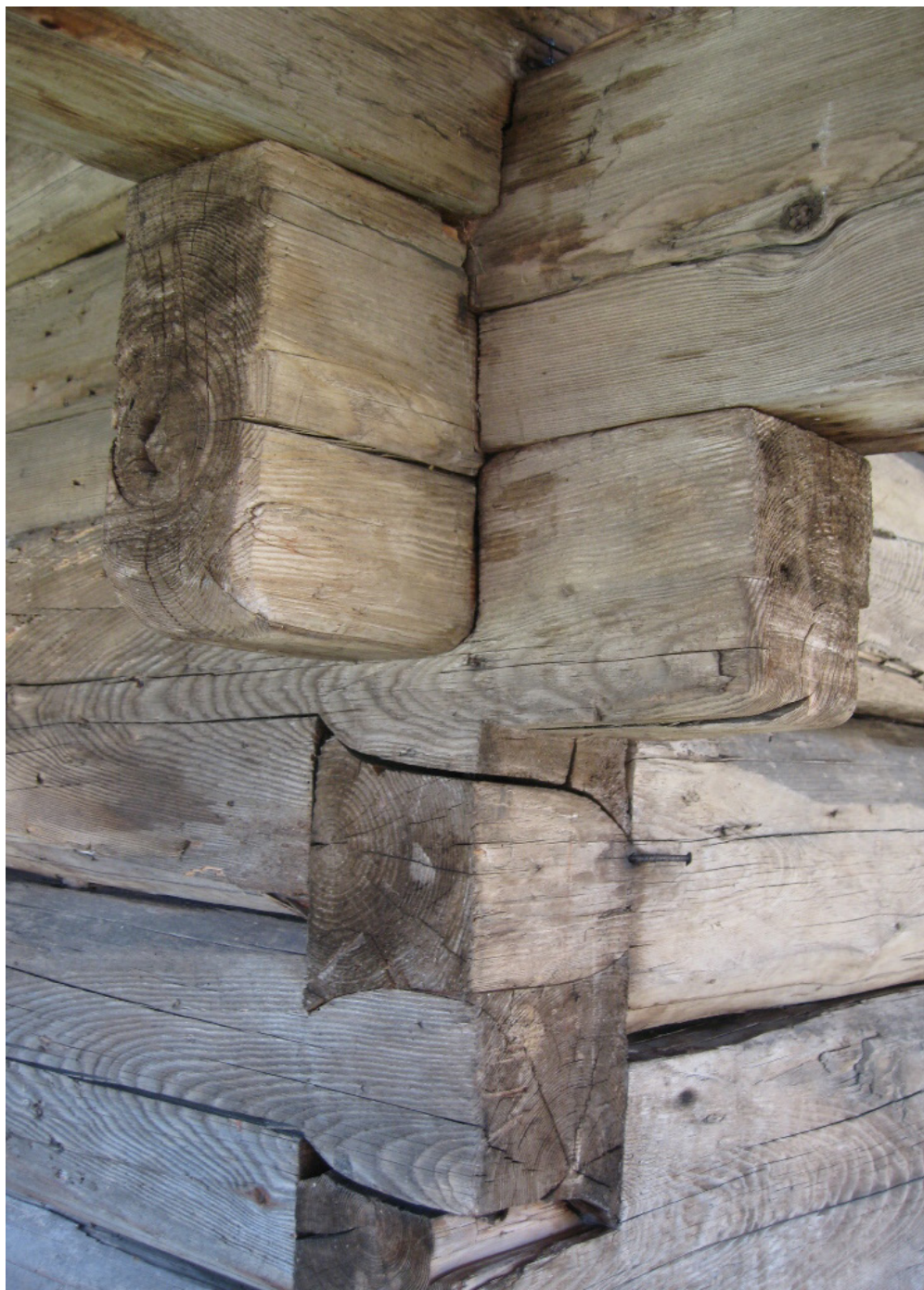
Fotografiji 28 in 29: Muzej na prostem, last Jožeta Kakerja. Kladna konstrukcija štiristrano tesanih brun, povezanih z dvojnimi utori lastovičjega repa . Vito Hazler, Podveža, 2003.
