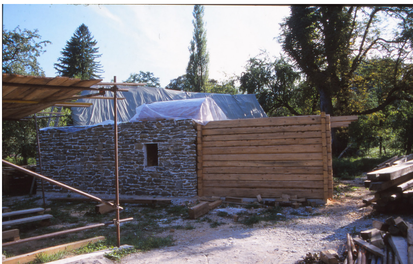
Fotografija 15: Rekonstrukcija kašče. Kamniti zid je grajen z apneno malto in krepkim dodatkom cementa. Tak zid je sicer trden, vendar zavajajoč, ker so graditelji spregledali pomen vogalno bistveno krepkejših kamnov, ki jih je treba polagati v smislu »šivanega« vogala, torej izmenično od tal navzgor, eden levi, eden desni in nato vsa plast kamnov od vogala do vogala postopoma navzgor. Vito Hazler, Polže, 2000.
