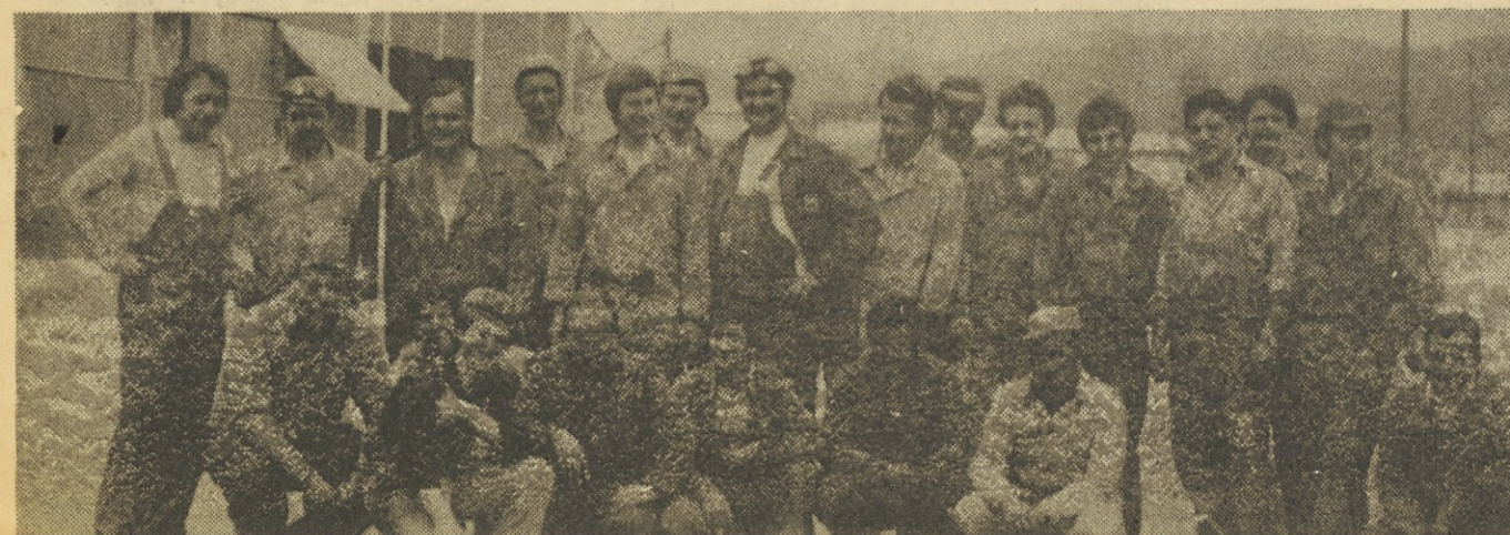
Skupina delavcev TOZD OV, ki je udarniško delala pri novogradnji
