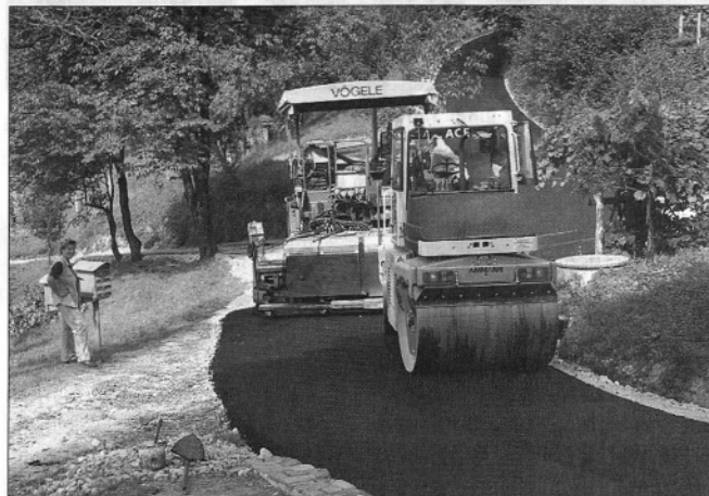
Asfalt v Kolovrat je po dveh letih, ko so tod dobili javni vodovod, zares velika pridobitev za krajanje (foto: Jože Miklavc)
