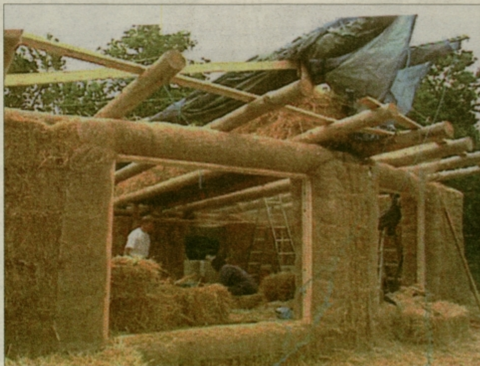
Gradnja hiše iz slamnatih bal, zidakov bodočnosti.
