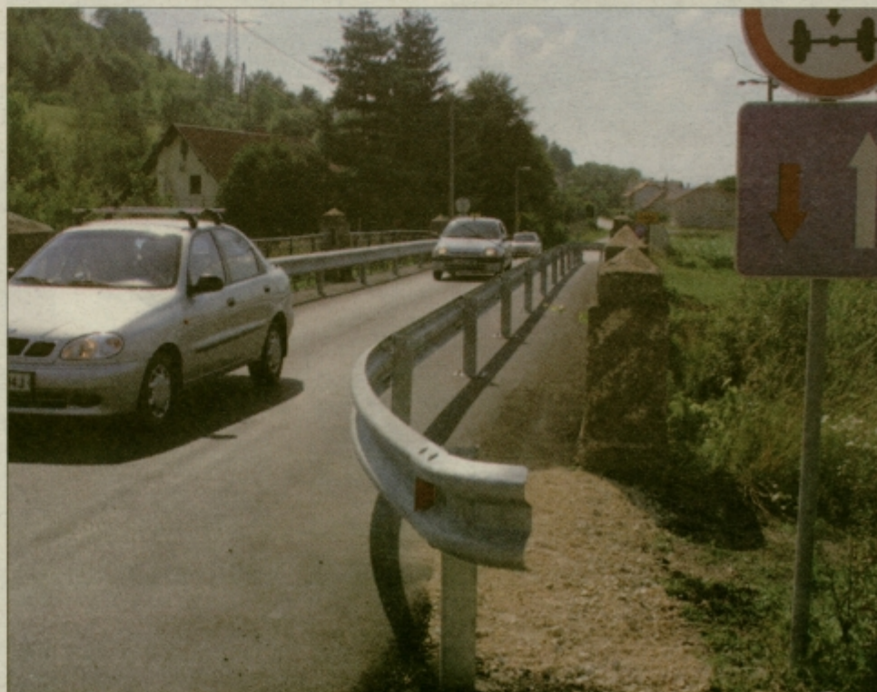
Na mostu čez Voglajno pri nekdanjem Pocajtovem mlinu imajo prednost vozila, ki vozijo v smeri proti Celju, na desni strani vozišča pa je z varnostno ograjo ločen hodnik za pešce.
