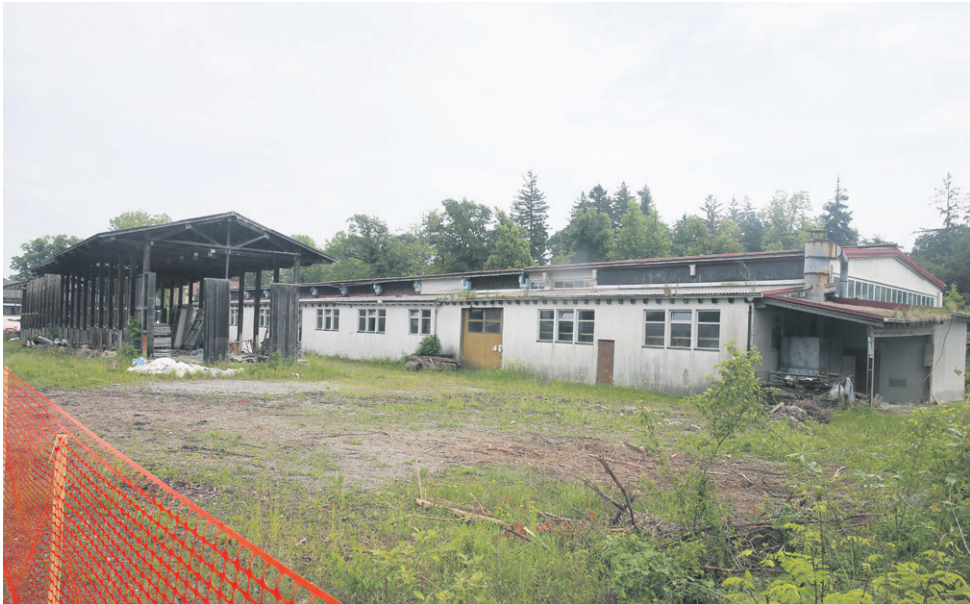
Na že dolgo časa zapuščenem območju, ki se ga Braslovčani sramujejo, bo škotsko družinsko podjetje do leta 2020 zgradilo največjo žago v Sloveniji.
