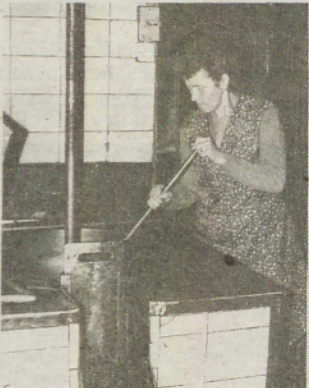
Praženje. Čeprav se v koritu vrti lopata, ki jo poganja električni motor, je koristno, da tu in tam pomagamo ročno.
