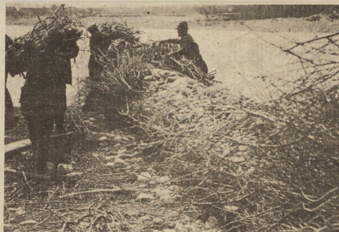
Tako se nekoč (pa tudi včasih še zdaj) z butarami iz šibja, v katere so dajali kamele, pregrajevali in usmerjali tok Mure, kadar je ta hotela iti »po svoje«.
