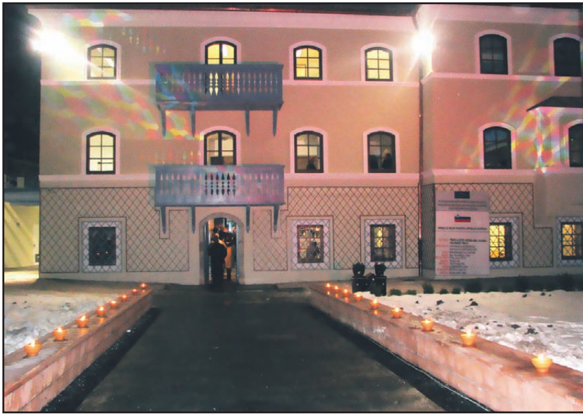
Zaradi številnih zapletov pri obnovi je vilo Bianco župan poimenoval kar »začarana vila«. Začara pa tudi z novo podobo; na večer otvoritve so jo osvetlili, lepa pa je tudi podnevi. Tako zunaj kot v notranjosti, ki še čaka na nove vsebine.
