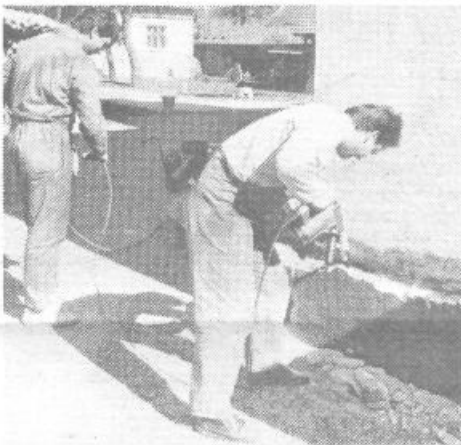
Gasilci pri pripravi zidu za izolacijo
