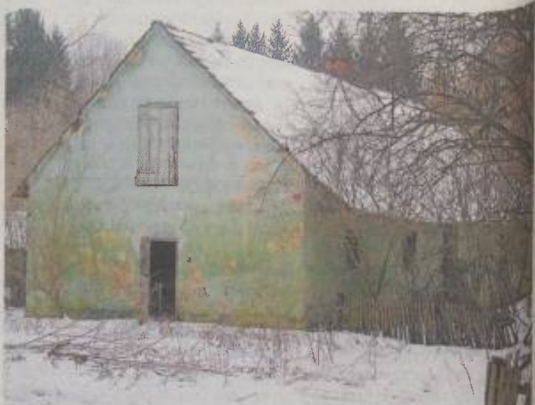
Nekdaj ugledna gozdarska hiša v Orlovščku je zapuščena in vse bolj propada. Foto: J. G.
