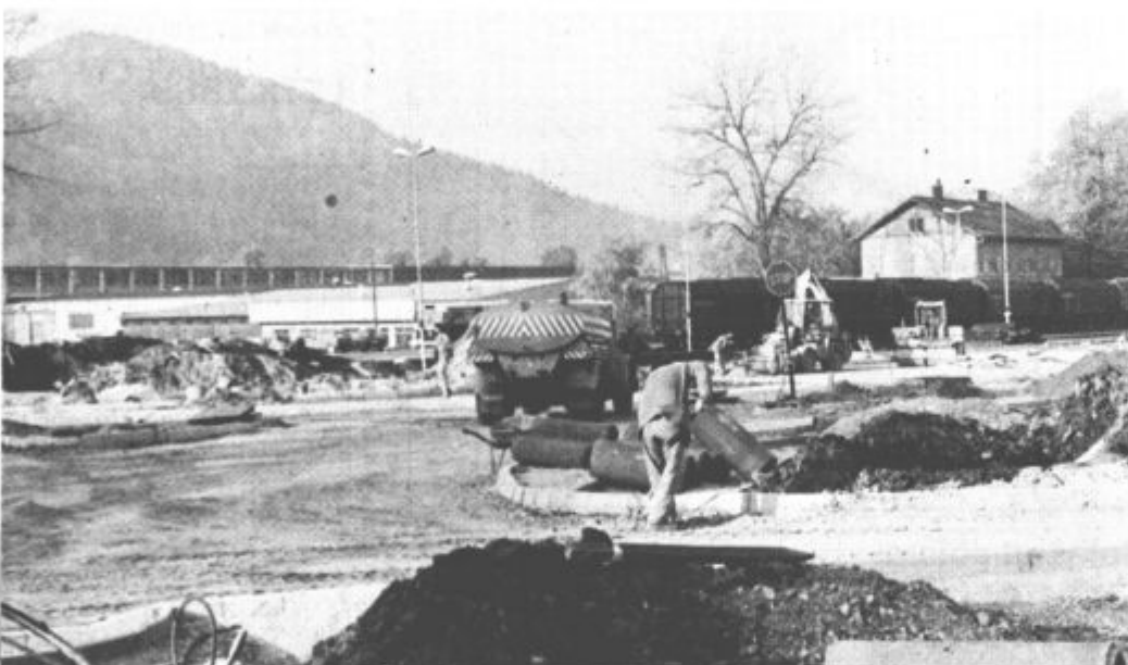
Pogled na križišče Tomšičeva - Koroška prejšnji teden, ta teden je del križišča že asfaltiran in po njem že poteka promet
