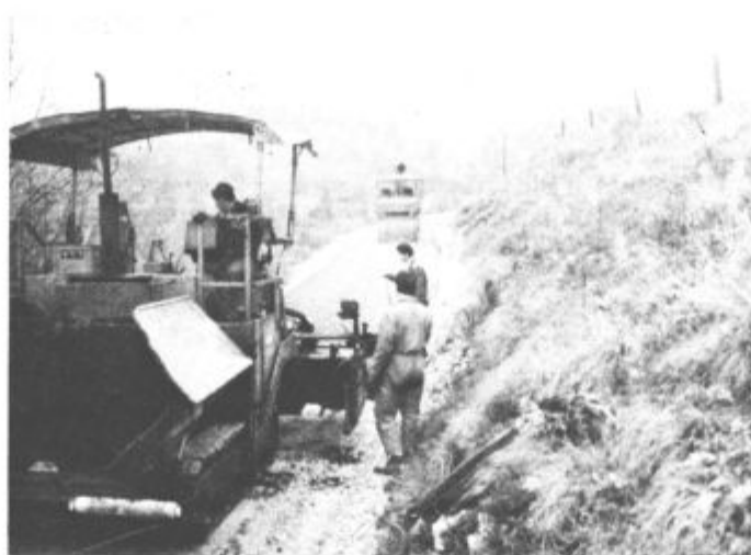
Ob našem obisku pri asfaltiranju ceste pri Dobrovljah je bilo megleno in slabo vreme.
