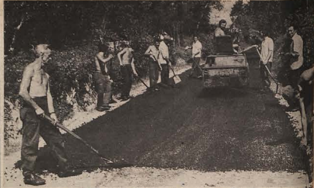
Prebivalci Slamne vasi in Boldraža, združeni v krajevni skupnosti, so s solidarnostno akcijo prostovoljnimi delom uresničili že vrsto zamisli. Za modernizacijo 600-metrskega odseka ceste — bo približal Metliki — so Boldražani z denarnimi prispevki in prostovoljnimi delom prispevali odstotkov celotne vrednosti del, ki bodo veljala 150.000 dinarjev. (Foto: M. Vesel)
