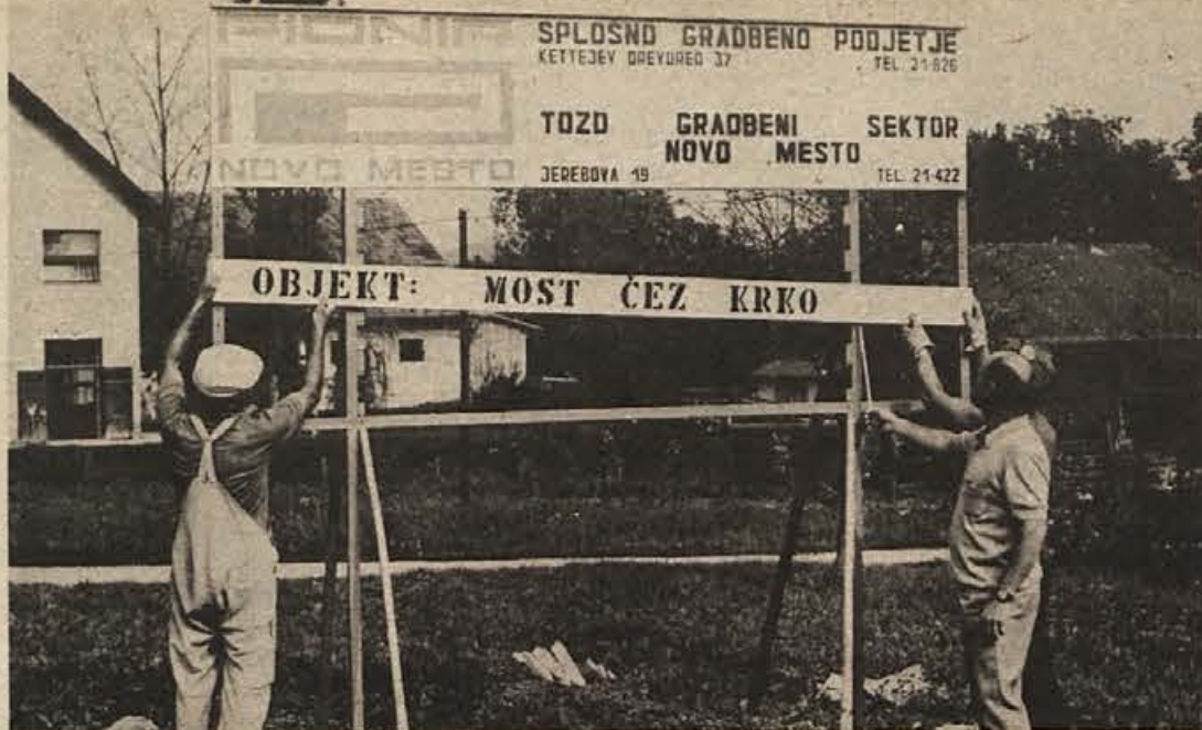
Po dolgotrajnih obljubah — sedaj prva lopata. Delavci SGP PIONIR so v ponedeljek začeli pripravljati gradbišče bodočega mostu čez Krko. Most bo povezan s cesto, ki bo šla med Gorenčevo hišo in toplarnjem pri veterinarski postaji. (Foto: M. Vesel)
