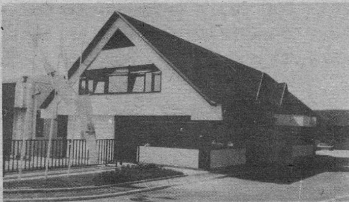
Delavci TOZD-a Kemija celjske Cinkarne v Ljubiji pri Mozirju so se zavedali, da brez visoko usposobljenih kadrov in sodobne opreme nadaljnji razvoj ni mogoč in zato so se lani odločili za gradnjo večnamenskega objekta. Namenjen bo računalniškemu centru in tehnološki pripravi dela.
