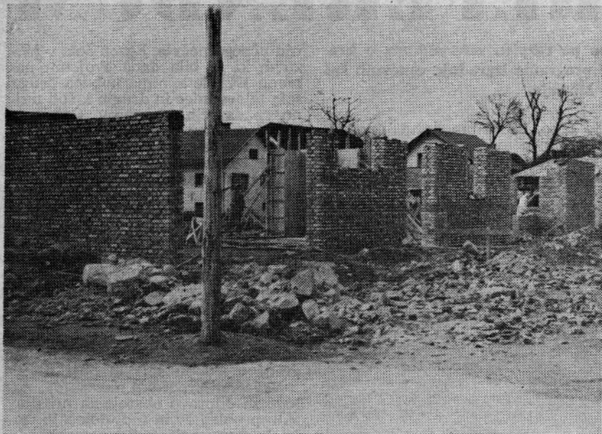
Gradnja nove šole na Rečici ob Savinji vidno napreduje
