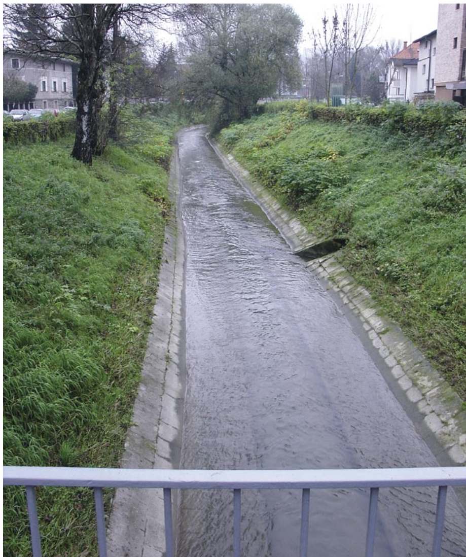
Slika 8 • Izpust iz razbremenilnika v odvodnik
