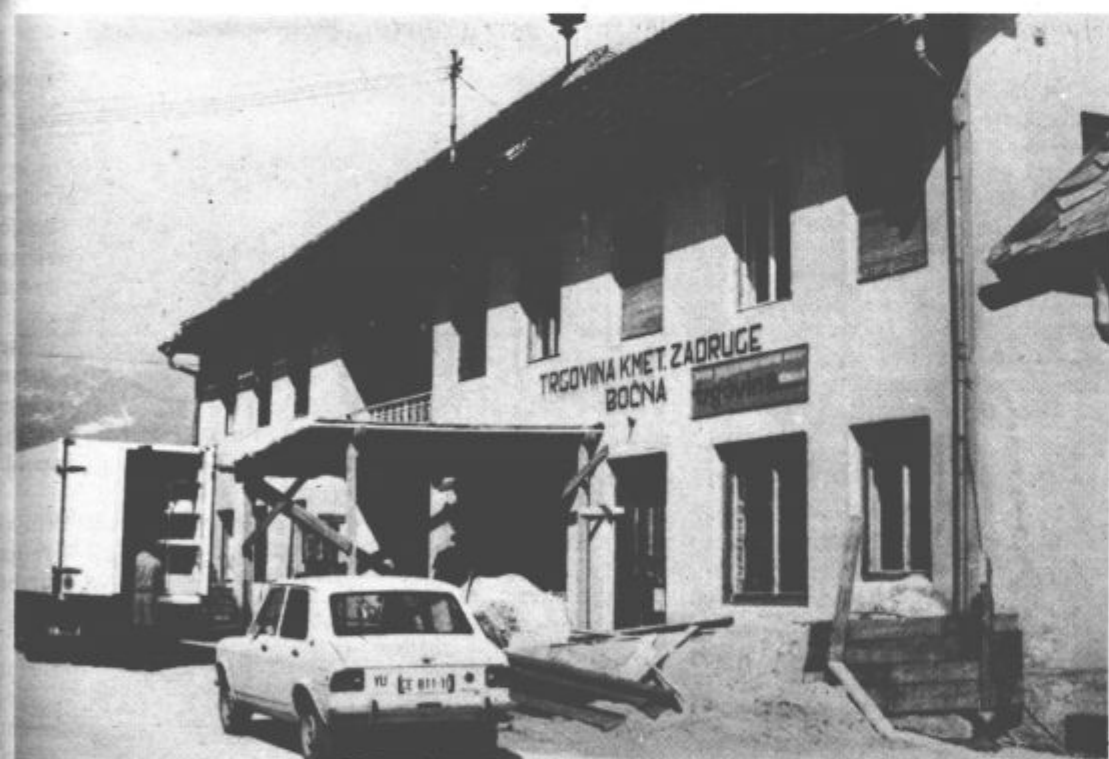
Po končani obnovi se bo ponudba izboljšala
