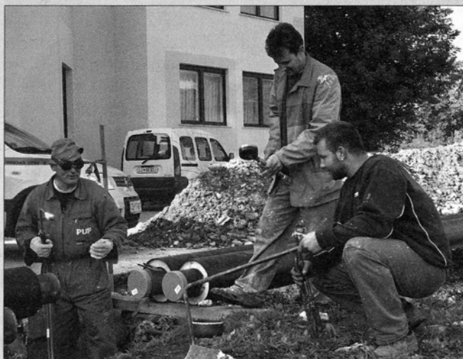
Na nazarskem toplovodu pred novo kurilno sezono še potekajo obnovitvena dela (foto: Marija Lebar)
