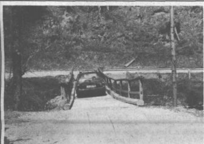
Takale brv za zgoščen in nekajmesečni promet gotovo ni primerna, še manj pa varna
