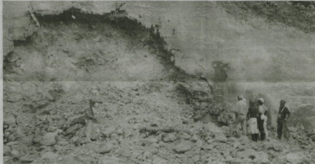
Po eksploziji so se pokazali obrisi bodočega predora. Do konca leta 2000, ko naj bi graditelji pri viaduktu Baba spet zagledali beli dan, bo potrebno še veliko podobnih pokov...
