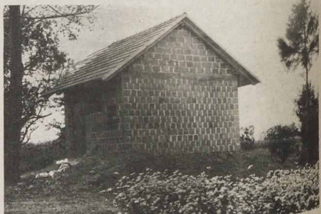
Na Stari Cesti v bližini osnovne šole že stoji lična hišica, v kateri je črpalnica za nov vodovod, na katerega bo priključenih 94 gospodinjstev.
