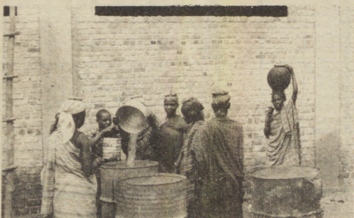
Voda za gradnjo večnamenske dvorane v kraju Jimbi
