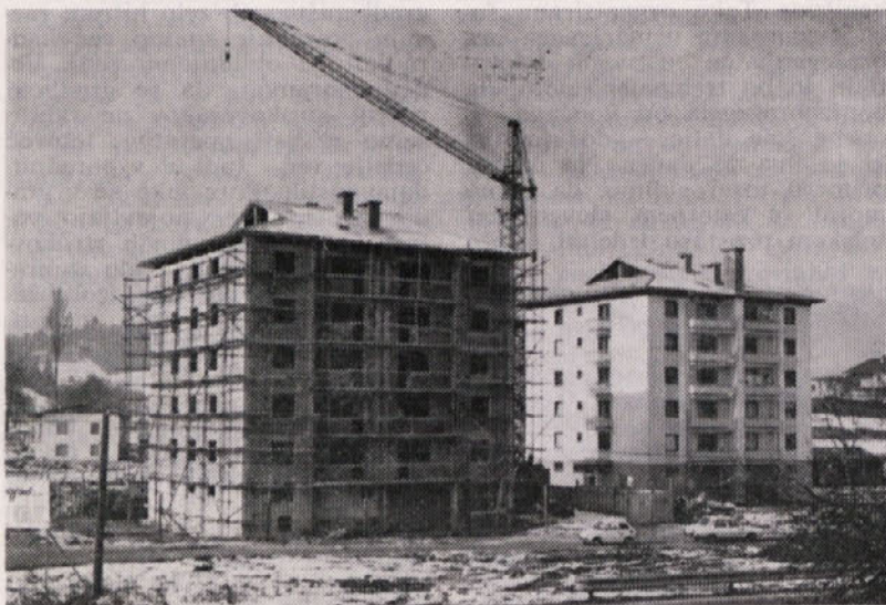
Na sliki sta stolpiča 4 (že vseljen) in 5 v Šentjurju. Drugi mora biti gotov do 4. 7. 1977, ob njem pa bosta zrasla še dva stolpiča, katerih rok je 29. 11. 1977.
