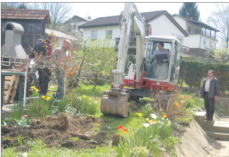
Pod nadzorom predsednika odbora za gospodarstvo Janka Lorbka (desno) so ta teden pričeli izkop za izgradnjo priklopa na fekalno kanalizacijo.
